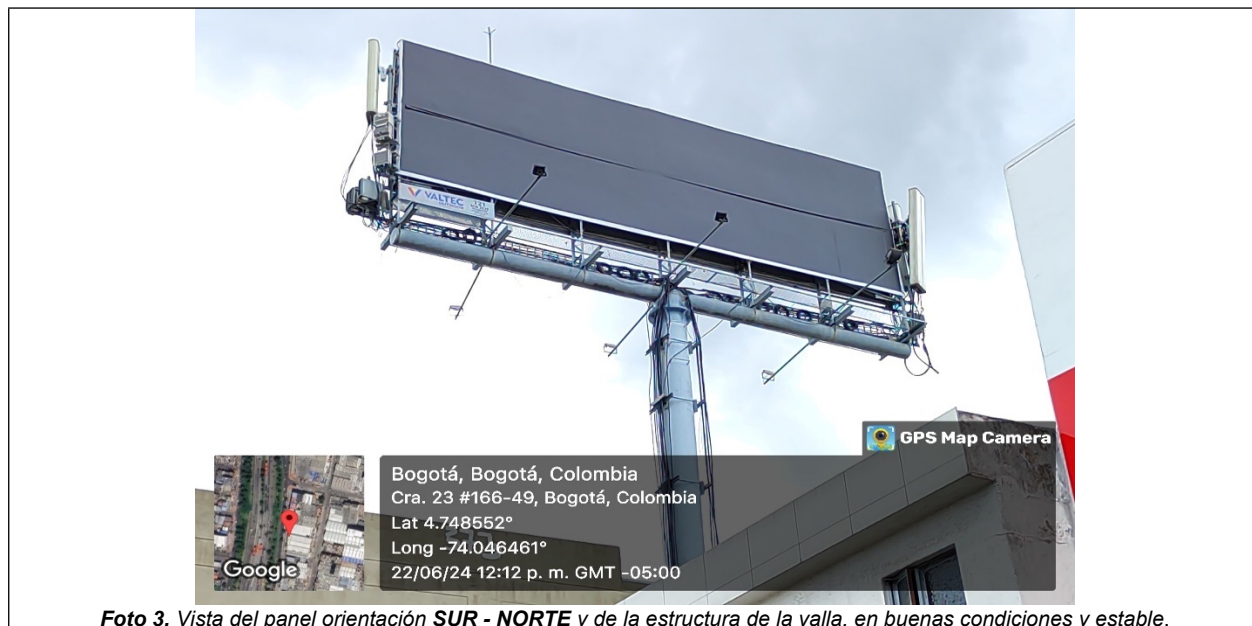
Foto 3. Vista del panel orientación SUR - NORTE y de la estructura de la valla, en buenas condiciones y estable.
