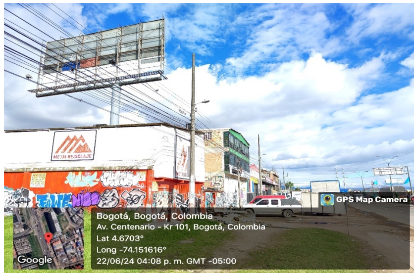
Foto 1 – Vista panorámica del sitio de origen de la valla en la Calle 17 No. 101 - 27 (dirección catastral), orientación OESTE - ESTE en la cual se evidencia que el panel publicitario fue desmontado.
